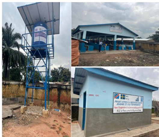
Quelques infrastructures dans le territoire de Dibaya
